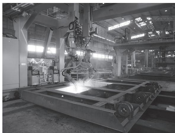
写真 11 防波壁パネルへの適用状況 Photo 11 Steel sea wall
